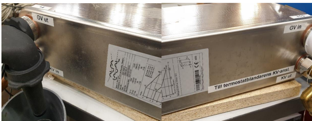
Figur 2. Ovanstående bildmontage visar de fyra anslutningarna på värmeväxlaren.
